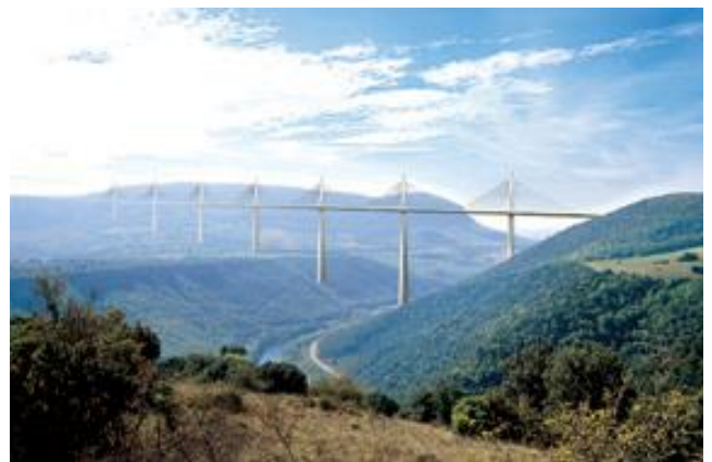
La topographie de la vallée du Tarn a été un élément déterminant pour la conception du viaduc de Millau (document DDE 48)
