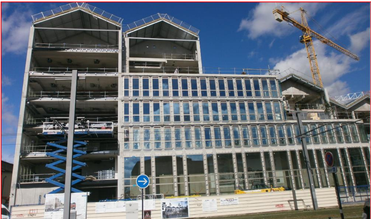
Chantier du siège régional du Crédit agricole dans le Quartier du Bassin à flot, architecte Jean-Michel Wilmotte
