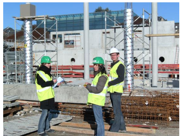
Suivi de chantier construction d'un centre aqua récréatif
