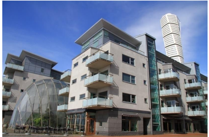
Western Harbour Malmö Suède
